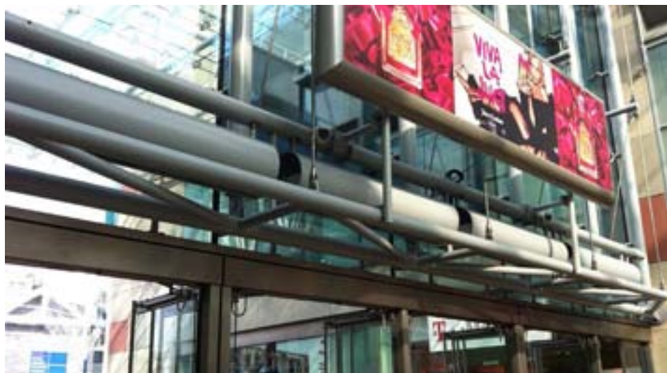
Figure 4.12.3.1 Door heaters
